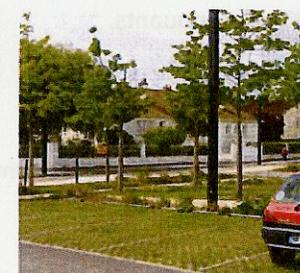
▶▶ Les places seront végétalisées au moyen de dalles ou pavés avec enherbement des joints. Une bande centrale pourra rester totalement enherbée, le sol sera renforcé pour assurer la pérennité de l'ouvrage lors de manoeuvre
